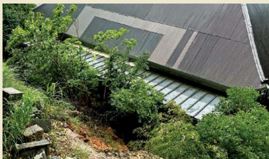
本堂裏山の崩落／白滝組 宗要寺
