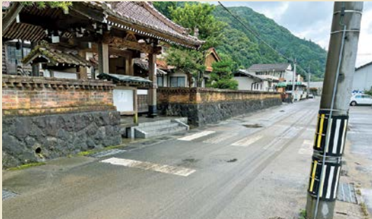
境内地への土砂流入／美祢西組 西音寺
