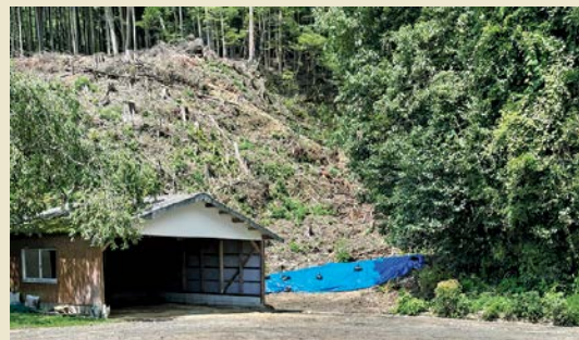
境内地内への土砂流入／豊田組 西念寺
