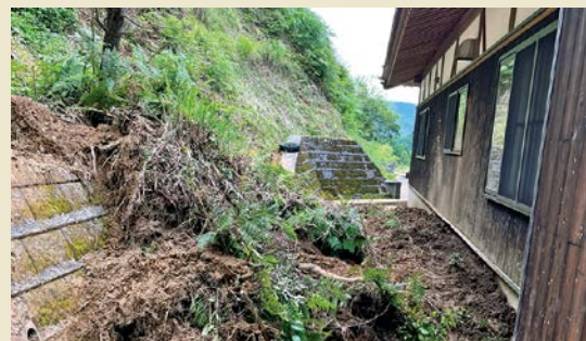
本堂裏山の土砂崩れ／美祢西組 明蓮寺
